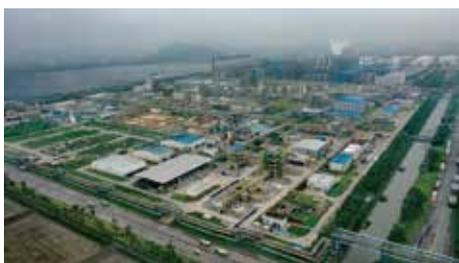
料以及建筑行业对聚合物日益增长的需求。该新装置于2020年开始建设，设计年产能为35,000吨，为其有机过氧化物业务生产两种关键中间体：叔丁基过氧化氢（TBHP）和叔丁醇（TBA）。有机过氧化物是高分子材料聚合和改性以及复合材料生产中必不可少的原材料。
