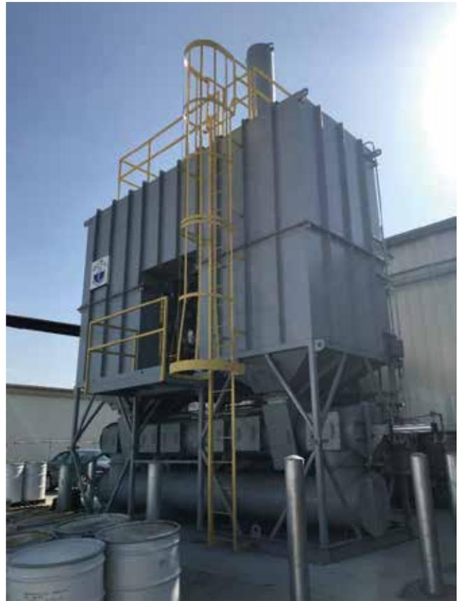
用于捕获和减少溶剂中的VOC和无组织排放物的RTO技术。照片由Ship & Shore Environmental提供。
