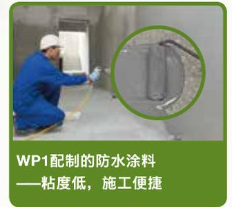
瓦克硅烷改性聚合物GENIOSIL® WP/XT 兼具聚氨酯的良好力学性能以及有机硅出色的防水性和耐候性，同时拥有对不同基面的优良粘结性能，可湿气固化。产品采用了瓦克 $\alpha$ -硅烷改性技术，冷法生产，提高生产效率。用其配制的防水涂料粘度低，施工便捷，不含有机溶剂和有机锡。GENIOSIL® WP/XT 硅烷改性聚合物是生产环保型防水涂料的出色材料，适用于屋面和厨卫间防水。
