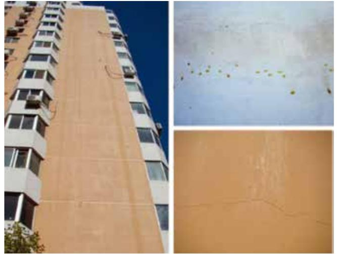
图3 ❖ ASTM 7190表面活性剂析出出水条纹测试。
